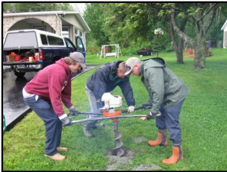
Test de percolation pour le dimensionnement des aménagements
