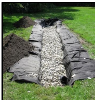
Tranchée d'infiltration en construction
